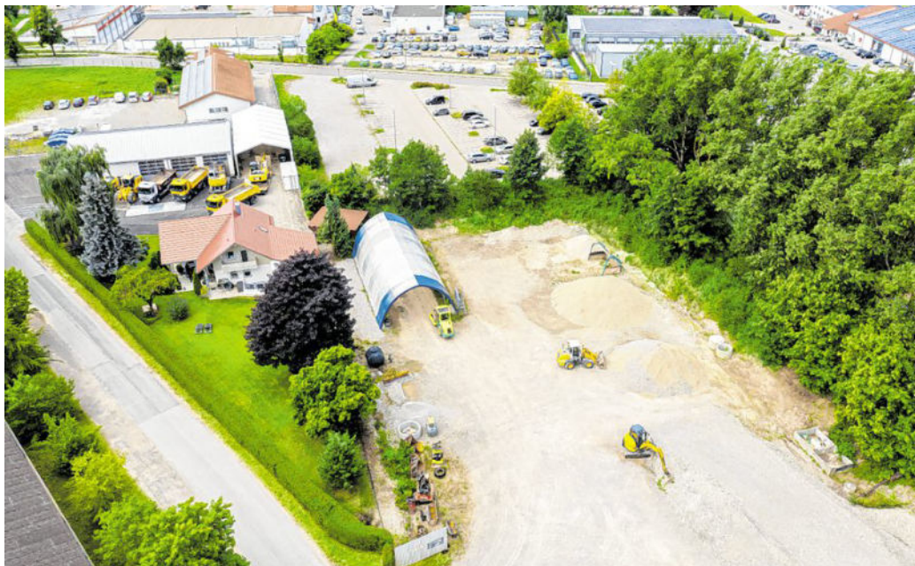
Das Firmengelände im Dreifaltigkeitsweg 9 in Schwabmünchen ist nun das Herzstück der HELU Erdbau.
